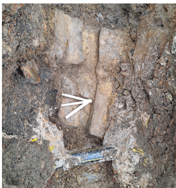
Horšovský Týn – Husovo náměstí: detail základu ohradní zdi hřbitova ve výkopu před západně od kostela sv. Apolináře
